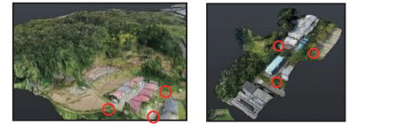
集水シミュレーションより危険箇所を推定。現地にて増水時の危険箇所を確認した。
